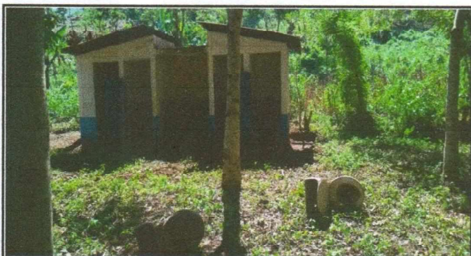
Foto 3: SUSTITUCION DE TAZAS DE INODORO
