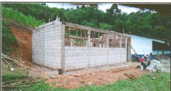
Foto 5: SUSTITUCION DE PAREDES DE AULA
