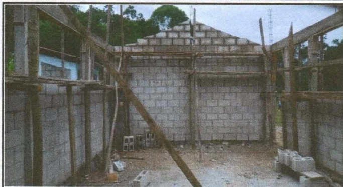
Foto 1: SUSTITUCION DE PAREDES
