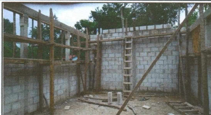
Foto 2: SUSTITUCION DE PAREDES DE AULAS DE TERCER GRADO
